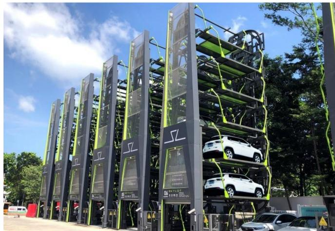
深圳企業奇見科技打造的垂直循環式立體車庫，單台設備佔用兩個半車位空間、高7層，可以停12至16部車。
